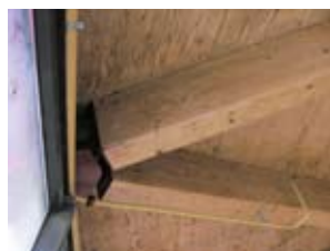
Estado de la estructura durante su paralización donde se aprecian los herrajes en los nodos de la malla triangulada
