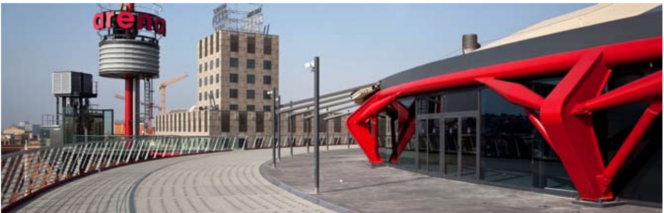
Detalle del estribo de tracción (un anillo de 46 cm de diámetro y 2 cm de espesor) que descansa sobre pilares acodados
